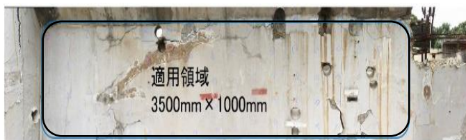
図 4 実構造物(プレキャスト桁)の検査対象領域
