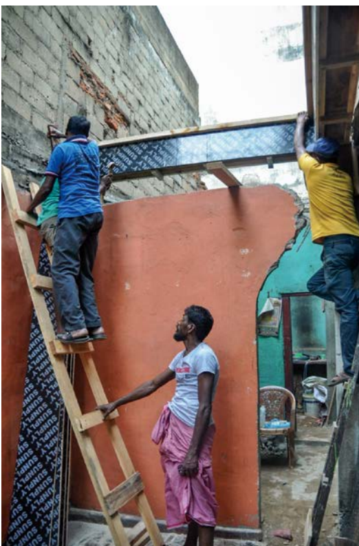
Fig. 4 Self-building of the Children's Learning Center 図4 セルフビルドによる子供の学習施設の建設
