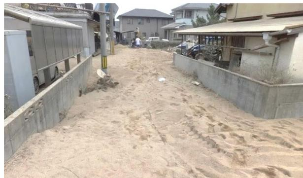
図 2-2-4-4 決壊場所近隣の砂礫堆積 2018 年 7 月 11 日撮影
