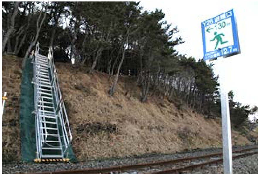
図 4-25 八戸線原状復旧(階上～久慈間 37.4km)での津波経路整備
