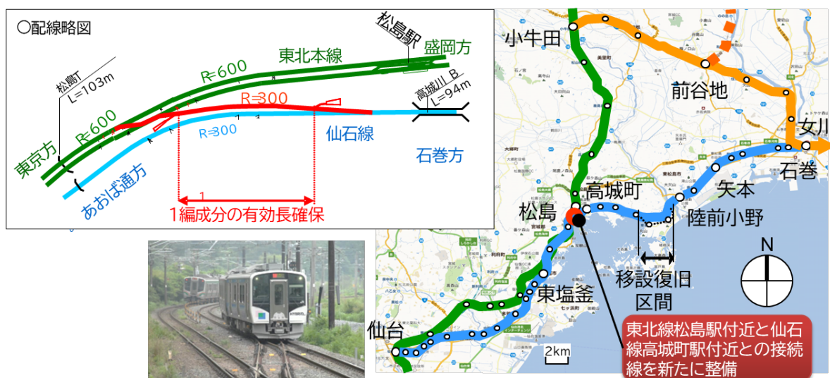
図 4-13 仙石東北ライン(仙石線・東北線接続線)の整備
