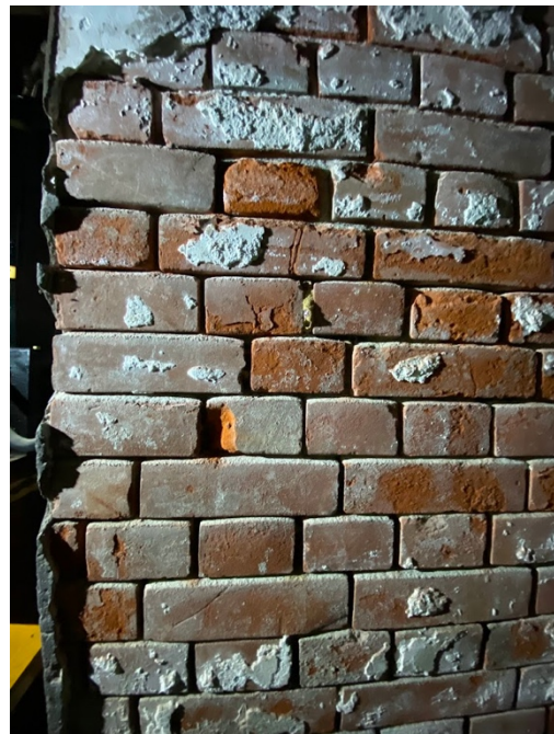
図 2.16 屋内に見られる小菅集治監製煉瓦 (著者撮影)
