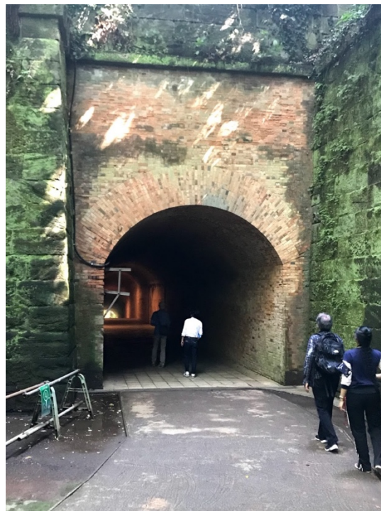
図3.4 北口から撮影した隧道(著者撮影)
