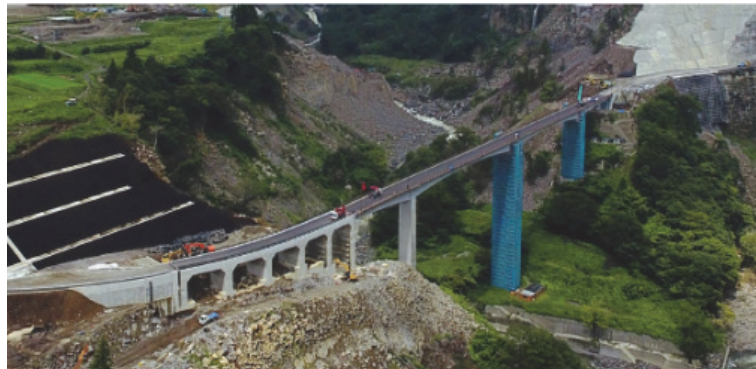
写真 3-1 阿蘇長陽大橋（復旧工事中）
