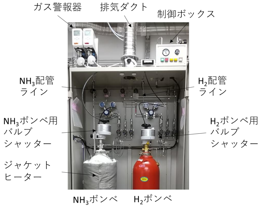
図 2-5 ガスシリンダーキャビネットの内部構造
