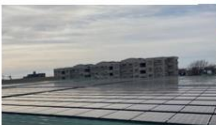
屋根上に太陽光モジュールを928枚設置しています
