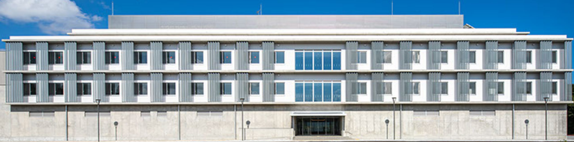
(西千葉から移転)東大と合築(2020.10竣工)
