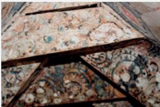
تصویر ۴.۷: سقف لترندیک، داخل استوپه شماره ۳ آلچی، در له هند (قرن ۱۳ میلادی) Photo: N.J. Chunka, 2018
