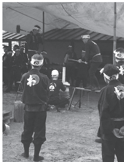
図4 火薬詰め作業
