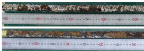
図 4 採取した腐食鉄筋の例 (D19)
