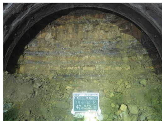
図2 トンネル切羽の例
