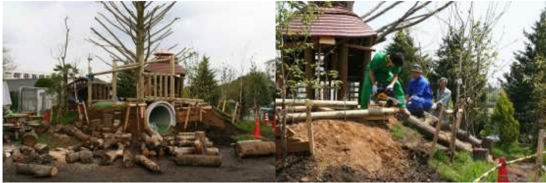
写真 1・2・1. 築山築造の様子
