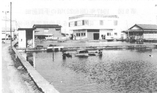
写真4 養魚池と新築家屋(1978年11月撮影)
