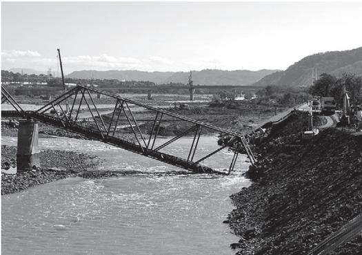
写真1 上田電鉄千曲川橋梁流失現場の様子
