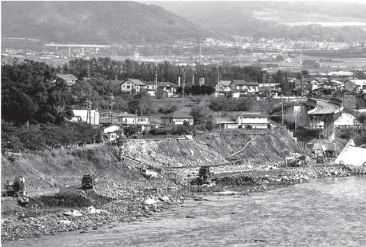
写真3 海野バイパスおよび千曲川堤防崩落の様子
