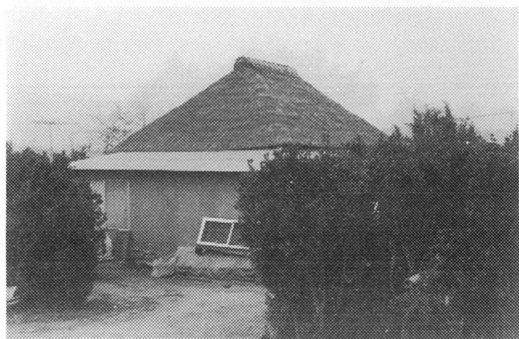
写真2 玉造町手賀新田地区の1漁家 (1978年11月) 棟の長さの短い直屋で、大棟を瓦で押さえた草葺きの寄棟屋根を残す。
