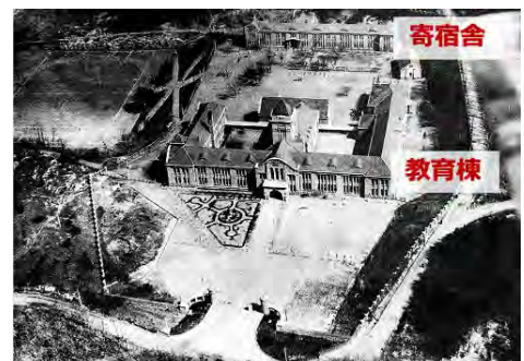
写真 2-2 青島中学校桜ヶ丘校舎
