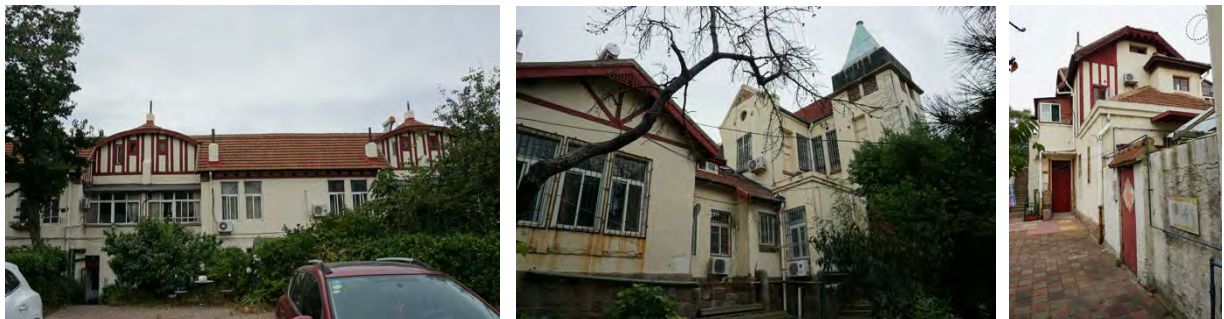
写真 2-7 東洋拓殖社宅敷地内にある現存の建物 (2019.9 筆者撮影)
