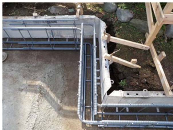
(b) U字ユニットと継手筋の配置
