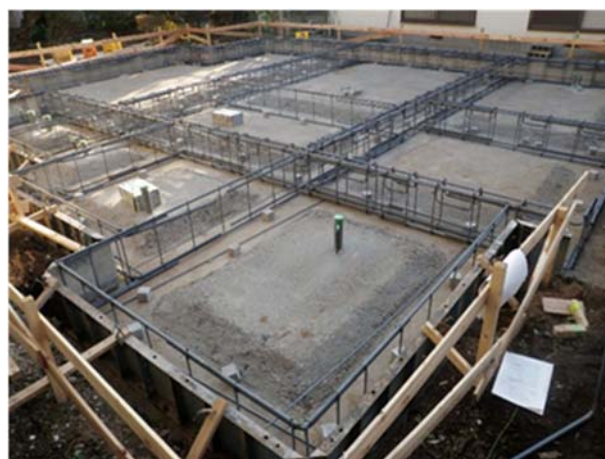
(d) 基礎梁配筋完成
