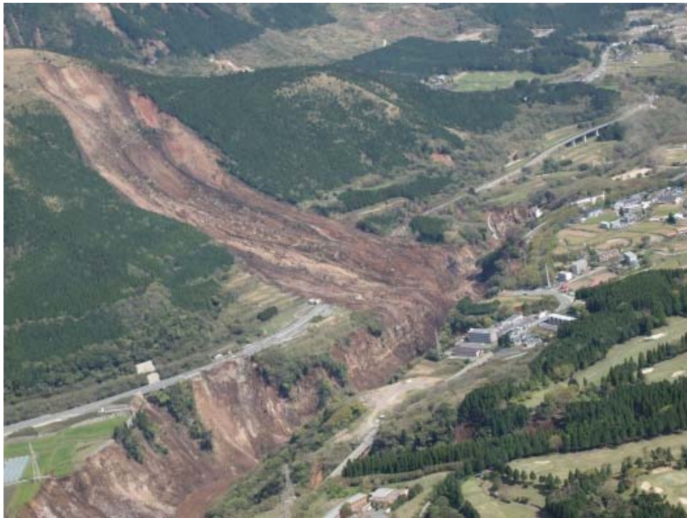
図-3.12 熊本地震によって発生した土砂移動（阿蘇大橋地区）
