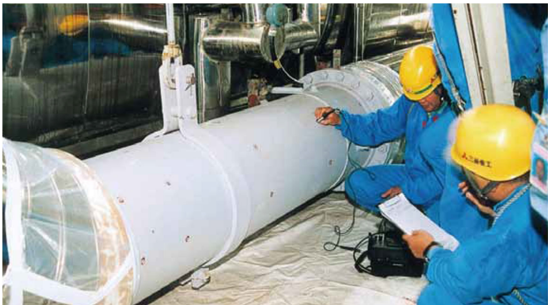
図 1-3 原子力発電所における配管肉厚検査の様子 [5]
