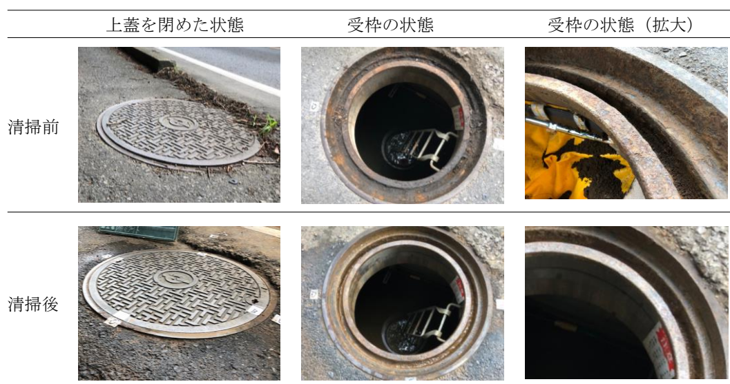
図 2-1-11 凸段差鉄蓋の清掃前と後の様子
