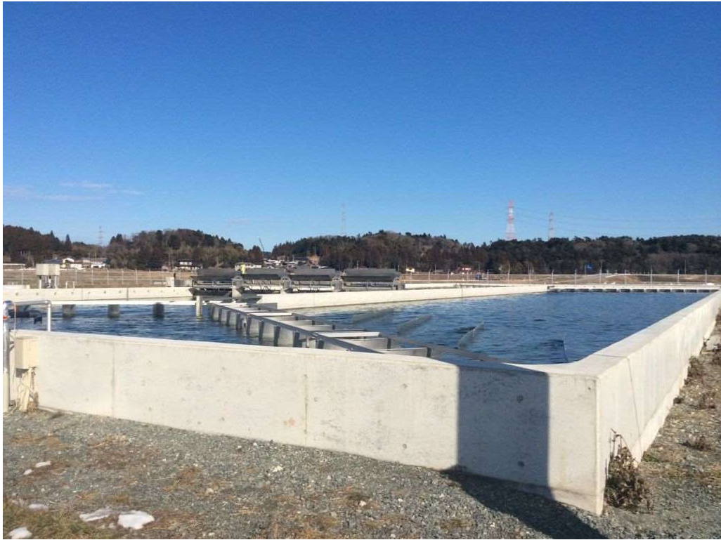
Fig. 1-2 Open raceway pond (1000 m 2 scale)
