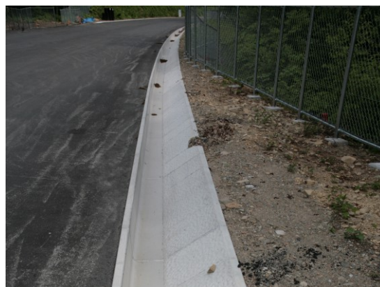
その他付帯施設：側溝の例 (甲子道路：福島県)
