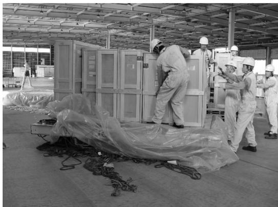
Fig. 1-2-33 空港内でパレットへ複数の梱包箱を固定するパレタイズ作業
