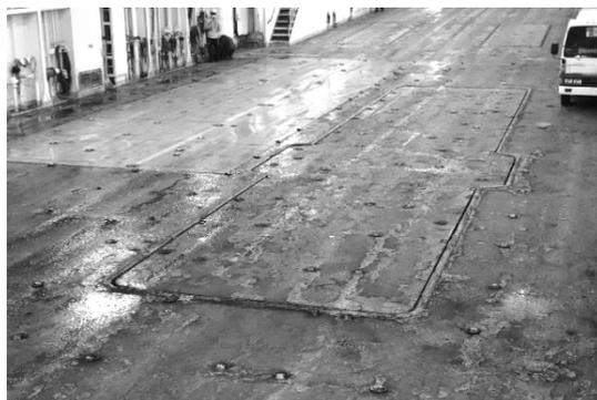
Fig. 5-3-31 床面のやや激しい凹凸の様子
