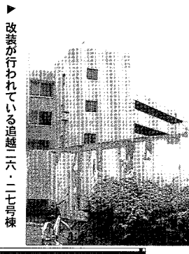
改装が行われている宿舎の一角
