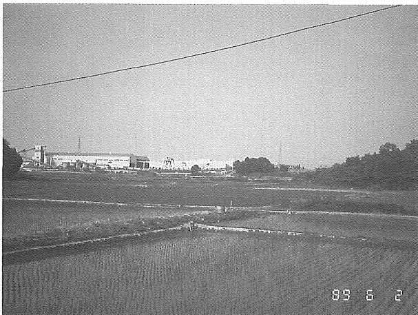
写真3 水海道市大生郷工業団地 (1989年6月2日撮影) 手前に広がる水田は工業団地西側の 谷地田である。手前の谷地田と工業 団地とは、約7mの高低差がある。
