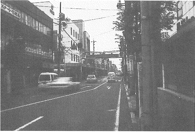
写真3 勝田中央方面からの表町の町並み
