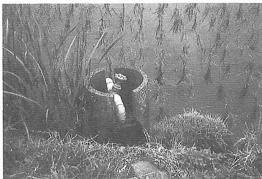
写真2 パイプライン灌漑の蛇口 (1991年5月撮影)
