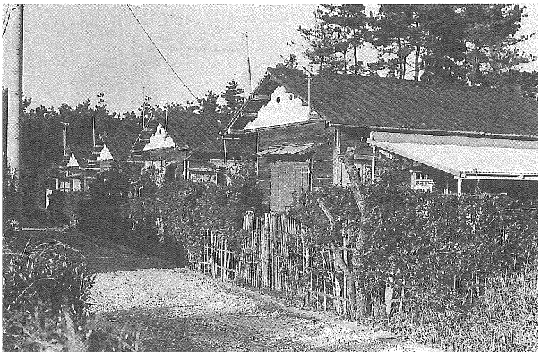
写真1 1969年に建設された公営住宅 海老台地区に建設された木造瓦ぶきで平屋の公営住宅である。 初期に造られた公営住宅に属し、この形式の住宅は、波崎地区 に3か所計30戸現存する。(1987年10月撮影)
