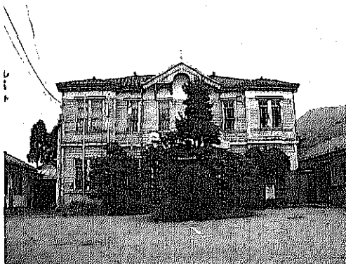
写真4 旧上高井郡役所 (2002年6月、小田撮影)
