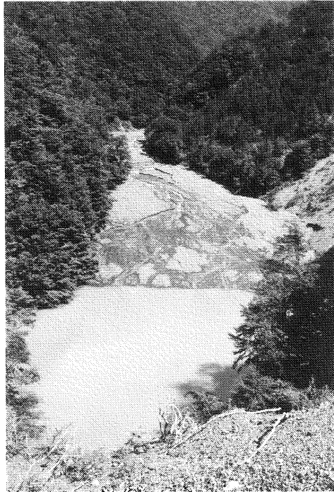
写真1 1989年8月豪雨による土砂流出と治山ダムへの堆砂 堆砂の前縁部は治山ダム上流100m(0.5測線付近)で停止した
