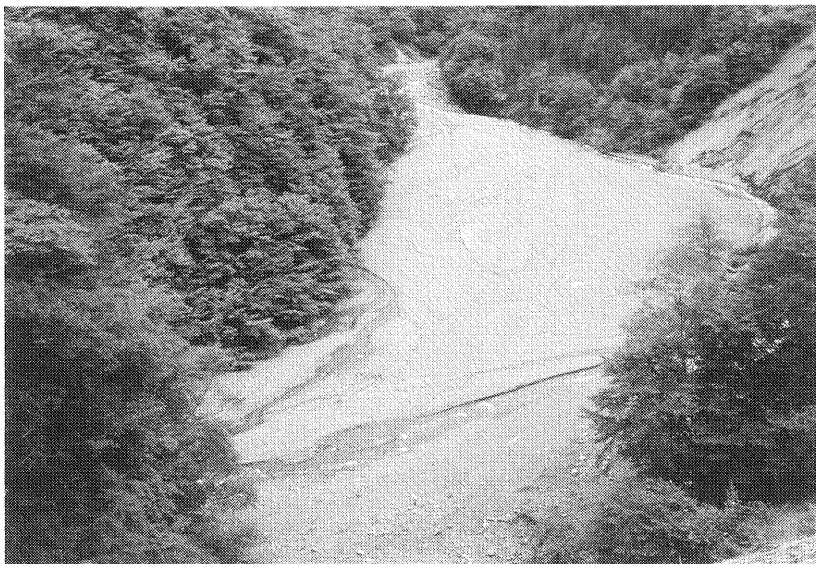
写真2 1989年9月豪雨による溪床堆積土砂の再移動とそれによる治山ダムの満砂
