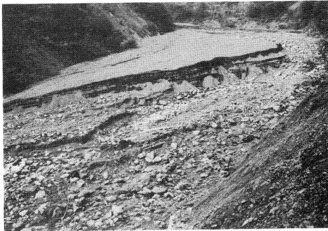
写真— 4. 8209 洪水による8208 洪水堆積物 （Ⅱ区間）の洗掘状況
