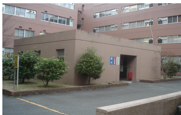
図1 危険物屋内貯蔵所（第3学群地区）
