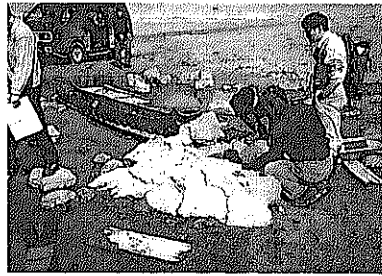
図7 乾燥地の水源。草原に掘られた浅井戸。岩を積んで崩れないようにしてある。深さ10mくらい。
