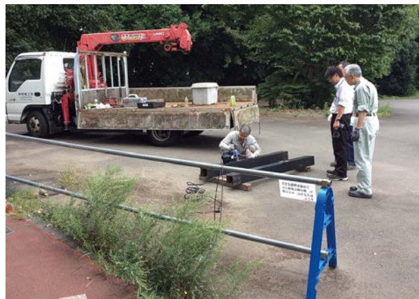
図15 SPEC・体育統合実験棟外での追加加工
