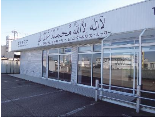
図3 富山モスク（富山県射水市） 閉業したコンビニエンスストアの敷地・建物を再利用。 (2014年9月撮影)
