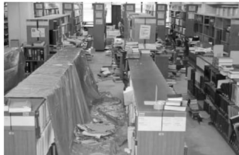
写真8 温水管破裂のため漏水 (医学図書館1階)
