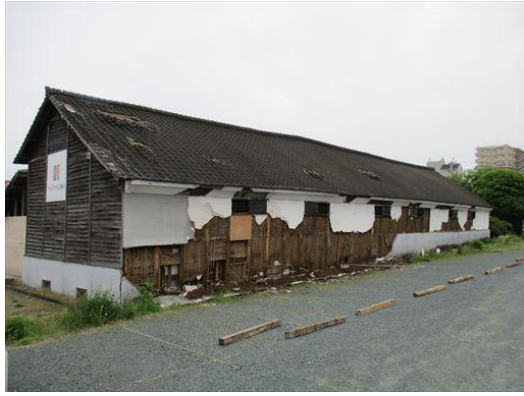
写真 19 外装材に被害を受けた木造建物
