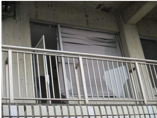
写真 13 大津町役場建物のガラスの被害
