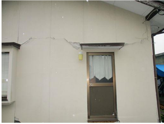
写真 29 外装材に被害を受けた木造建物
