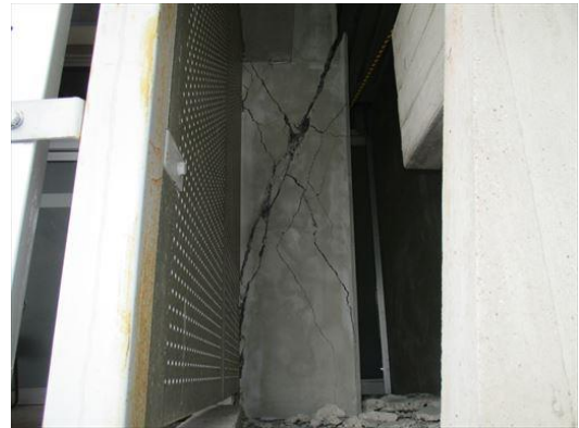
写真 14 大津町役場建物の柱のせん断ひび割れ
