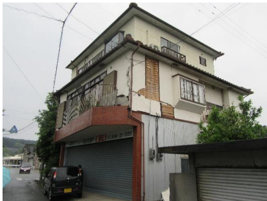
写真 49 外装材が被害を受けた木造建物
