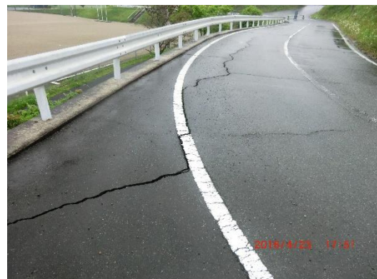
写真 52 亀裂が入った道路
