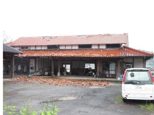
写真 50 屋根瓦が被害を受けた木造建物
