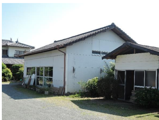
写真 62 外装材に被害を受けた鉄骨造建物
