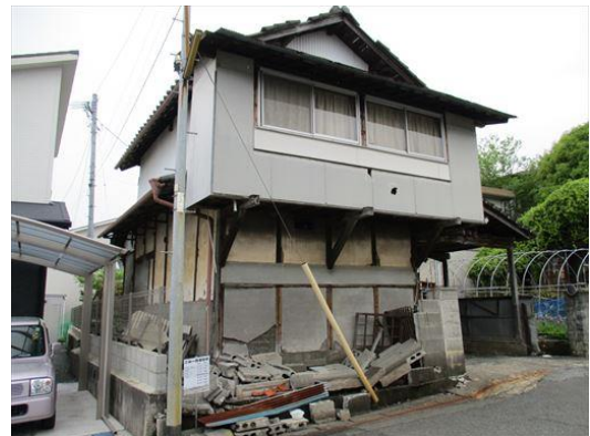
写真 18 ブロック塀の被害
