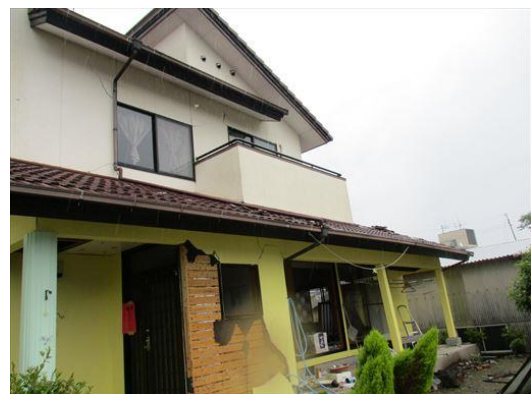
写真 28 外装材に被害を受けた木造建物
