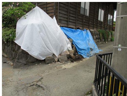
写真10 擁壁の被害(範囲外)
