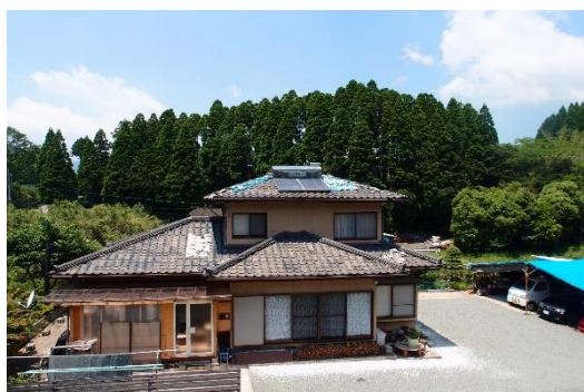
写真 71 瓦屋根に被害を受けた木造建物
