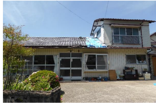
写真 108 瓦屋根に被害を受けた木造建物
