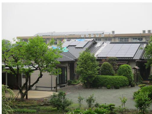
写真 42 瓦屋根に被害を受けた木造建物 (範囲外)
