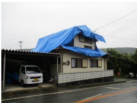
写真 27 瓦屋根に被害を受けた木造建物
