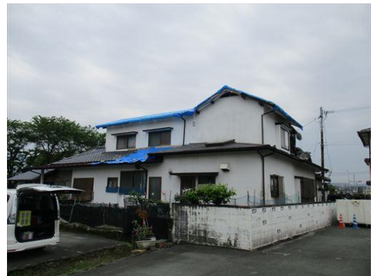
写真8 瓦屋根が被害を受けた木造建物
