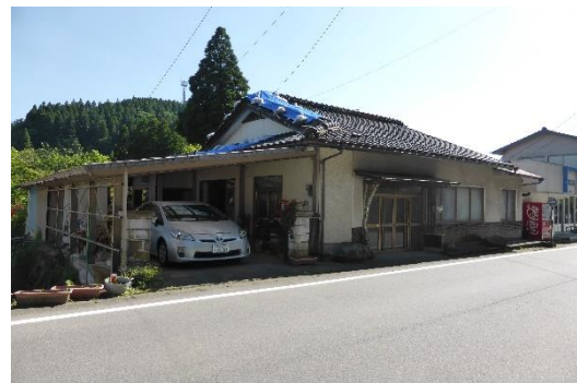
写真 90 瓦屋根に被害を受けた木造建物
