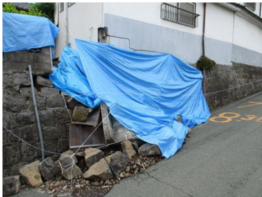
写真 17 擁壁の被害
