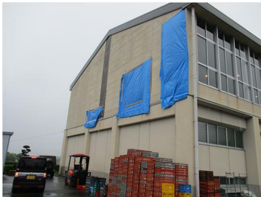
写真 23 体育館の外装材の被害
