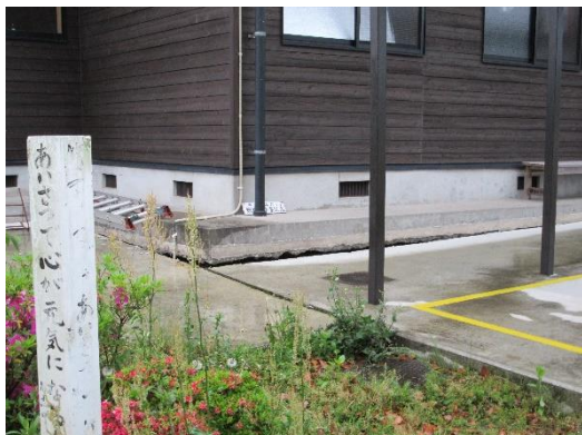
写真 51 基礎の浮き上がりが見られた木造建物
